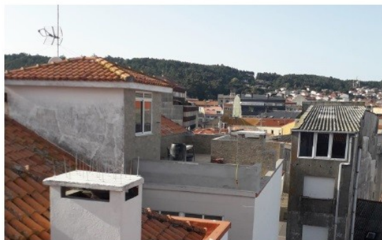
ESTADO ACTUAL DE LAS INTERVENCIONES QUE SE ESTÁN EJECUTANDO EN LA CUBIERTA
