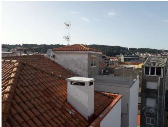
FOTOGRAFÍA DONDE SE APRECIA LA ELIMINACIÓN DE UNA SERIE DE FALDONES DE CUBIERTA Y EL ACONDICIONAMIENTO DE DICHA ZONA PARA TERRAZA, LA CUAL TIENE VISTAS HACIA FINCA COLINDANTE.
