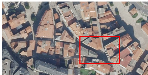
Fotografía do estado posterior á execución das obras sen título habilitante. (Voo fotogramétrico do Plan Nacional de Ortofotografía Aérea (PNOA) del 1 de outubro de 2023)
